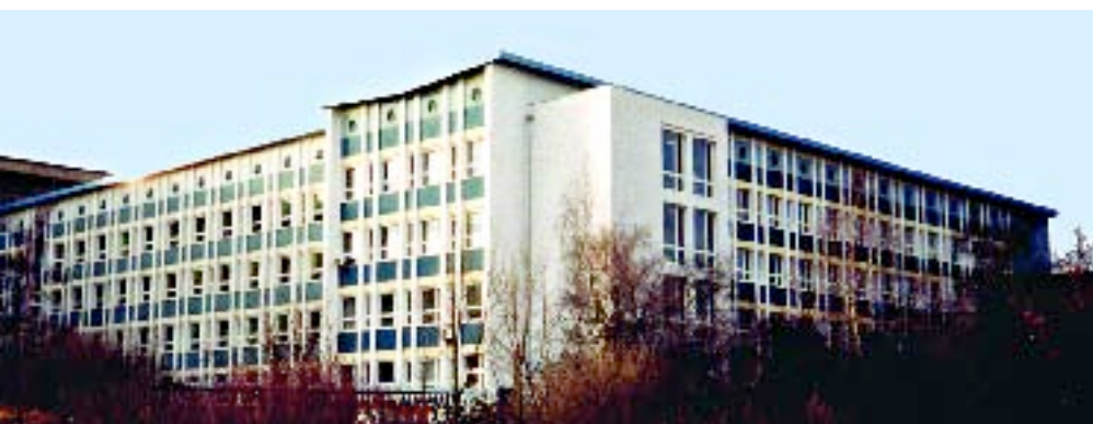
Das Pharmazeutische Institut, zwischen 1963 und 1967 errichtet, wurde in zwei Bauabschnitten grundlegend saniert
