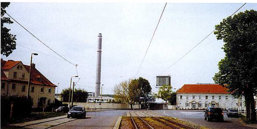
Haupttorplatz Leuna-Werke – Schnittstelle zwischen Werk und Gartenstadt „Neu-Rössen“
